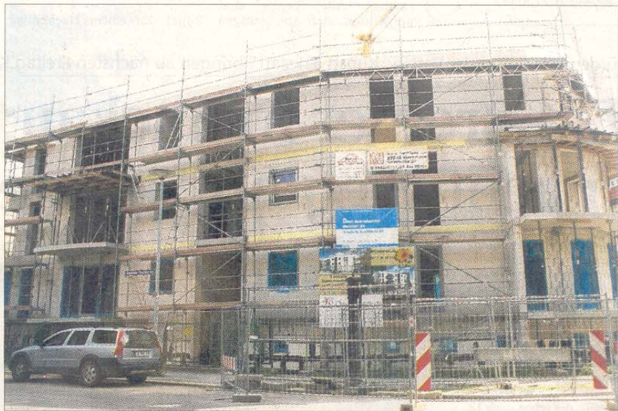
Der Rohbau an der Alexander-Puschkin-Straße: Jetzt geht der Innenausbau los. Fotos (3): Ariane Budberg
