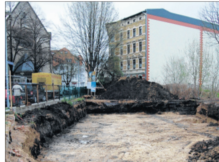
Derzeit befindet sich auf der Fläche noch eine große Baugrube.
